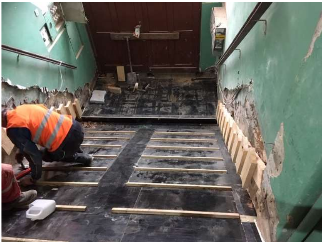
Die viel zu steile Treppe in den Gottesdienstraum wird erneuert.
