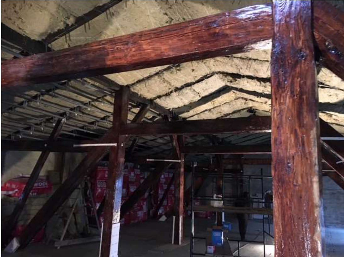
Die Balken im Dachboden sind imprägniert und das Dach gedämmt.
