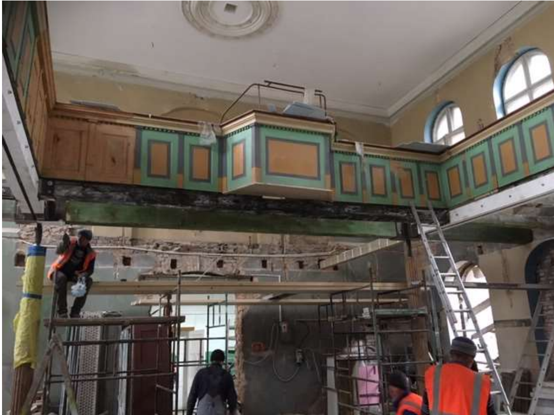
Arbeiten im Gottesdienstraum. An der linken Seite ist die Empore bereits bearbeitet.
