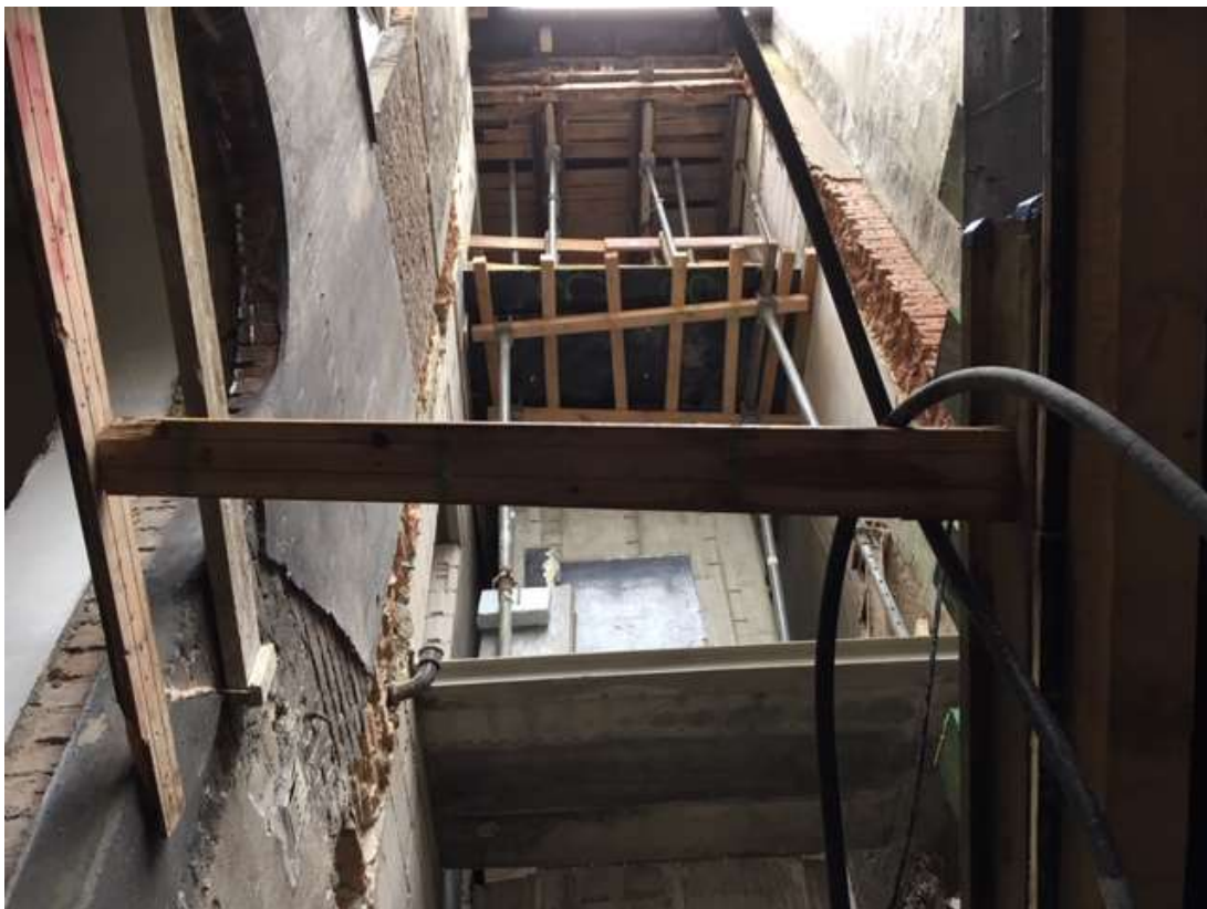
Im Hintergrund ist der Schacht für den Fahrstuhl bereits fertig.
