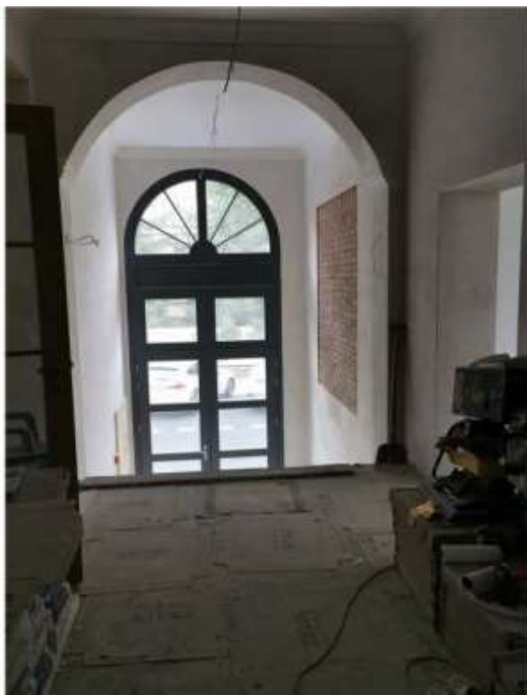
Blick auf die Hauseingangstür
