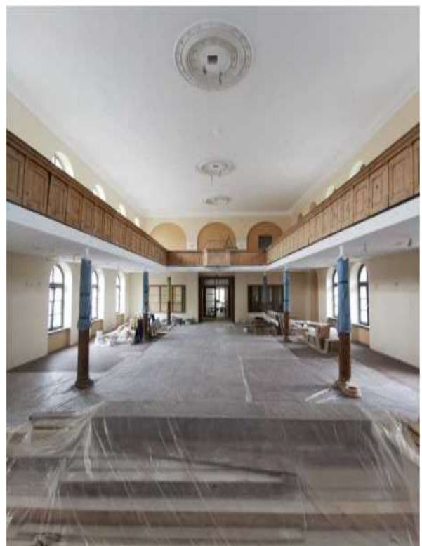
Blick vom Baptisterium zur Eingangstür
